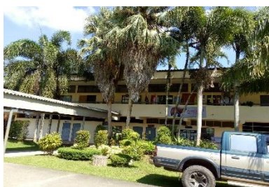
อาคารเรียน ๒๐๘ ปีที่สร้าง ๒๕๒๕
