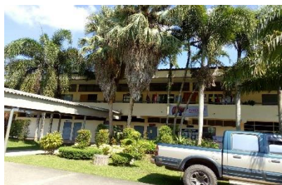
อาคารเรียน ๒๐๘ ปีที่สร้าง ๒๕๒๕
