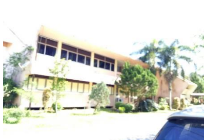
อาคารเรียน CS๒๑๗B ปีที่สร้าง ๒๕๒๗
