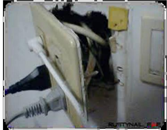
สภาพชำรุดอุปกรณ์ไฟฟ้า
