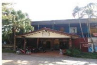
อาคารเรียน ป.1ฉ ปีที่สร้าง 2523
