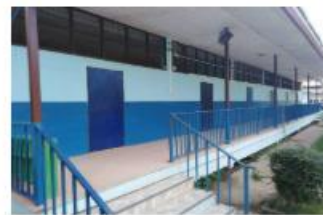
อาคารเรียน สปข.103/26 ปีที่สร้าง 2525
