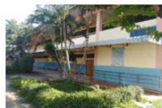
อาคารเรียน สปข.105/29 ปีที่สร้าง 2540
