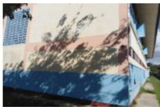
อาคารเรียน สปข.105/29 ปีที่สร้าง 2532
