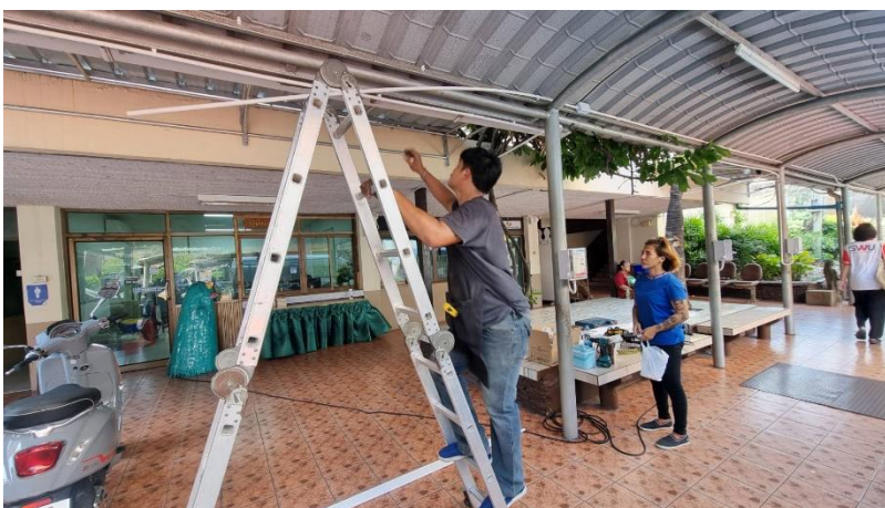
ภาพบรรยากาศการติดตั้ง
