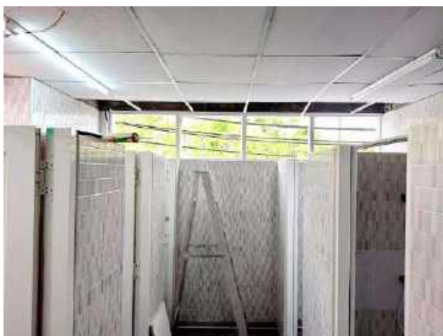
ภาพที่ ๒๔ การเปลี่ยนกระจกหน้าต่างห้องน้ำที่ชำรุดเป็นอันตรายกับนักเรียน และซ่อมแซมแผ่นฝ้าเพดาน
