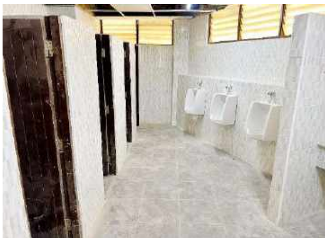
ภาพที่ ๒๓ การเปลี่ยนบานประตูไม้ที่ผุพังเป็นอันตราย เป็นประตูอะลูมิเนียมที่แข็งแรง
