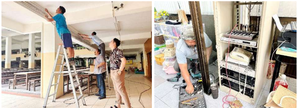
ภาพที่ ๑๐ ปรับปรุงระบบเสียงตามสาย และระบบเตือนภัยต่าง ๆ ในทุกชั้นของทุกอาคาร
