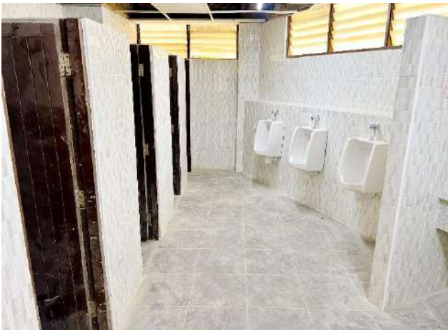
ภาพที่ ๑๗ เปลี่ยนบานประตูไม้ที่ผุพังเป็นอันตราย เป็นประตูอะลูมิเนียมที่แข็งแรง
