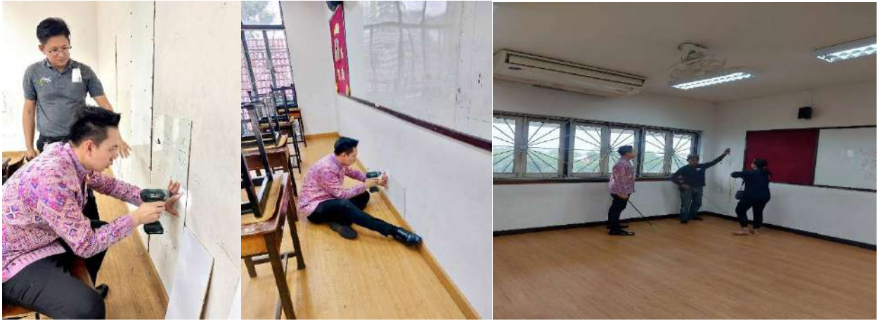
ภาพที่ ๑๓ การซ่อมแซมผนังของอาคารเรียนที่ชำรุด
