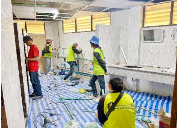
ภาพที่ ๑๖ การซ่อมแซมระบบท่อน้ำ ระบบสุขาภิบาลภายในห้องน้ำ ทำให้สามารถใช้งานได้
