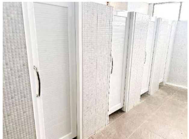
ภาพที่ ๑๗ เปลี่ยนบานประตูไม้ที่ผุพังเป็นอันตราย เป็นประตูอะลูมิเนียมที่แข็งแรง
