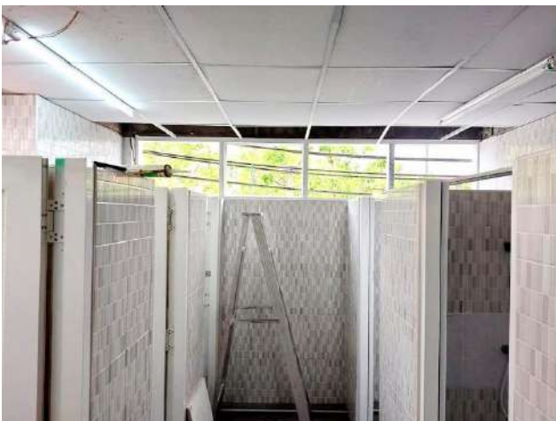
ภาพที่ ๑๘ เปลี่ยนกระจกหน้าต่างห้องน้ำที่ชำรุดเป็นอันตรายกับนักเรียน และซ่อมแซมแผ่นฝ้าเพดาน
