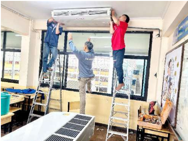
ภาพที่ ๘ ปรับเปลี่ยนเครื่องปรับอากาศที่ชำรุดในห้องเรียน
