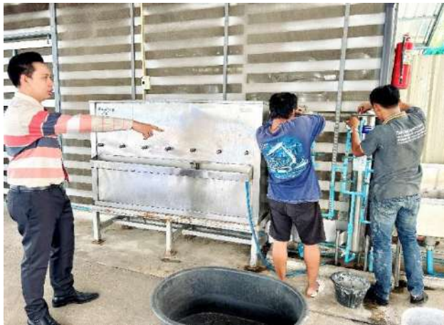
ภาพที่ ๔ การเปลี่ยนสารภายในเครื่องกรองน้ำและล้างเครื่องกรองทุกจุด
