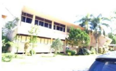
อาคารเรียน CS๒๑๗B ปีที่สร้าง ๒๕๒๗
