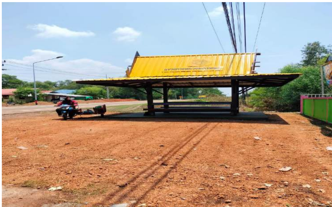
รูปภาพที่ ๖ กรมทางหลวงจัดสร้างศาลาพักผู้โดยสาร เพื่อให้นักเรียนได้พัก
