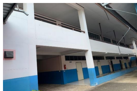
อาคารเรียน สปช.๑๐๕/๒๙ ปีที่สร้าง ๒๕๕๖
