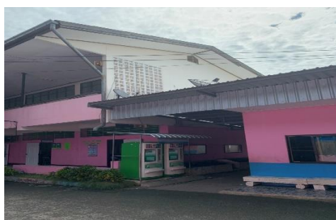
อาคารเรียน สปช.๑๐๕/๒๙ ปีที่สร้าง ๒๕๕๐
