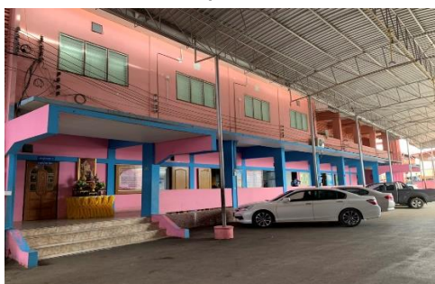
อาคารเรียน สปช.๒/๒๘ ปีที่สร้าง ๒๕๓๔
