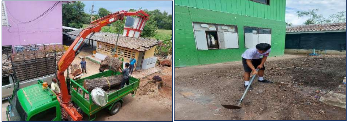
ภาพกิจกรรมปรับภูมิทัศน์เพื่อเสริมสร้างความปลอดภัยในสถานศึกษา
