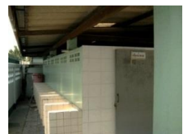
ห้องน้ำ-ห้องส้วม
